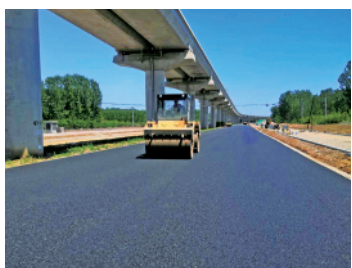
已经修好的道路路面。
