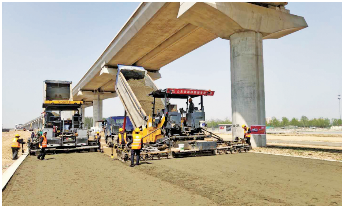
◀ 两台摊铺机齐头并进,将道路摊铺平整。
