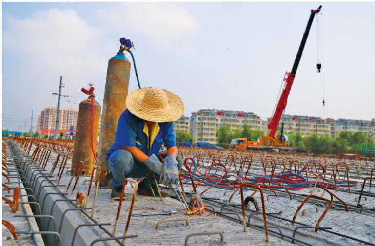
工人正在嘉富路桥的桥面板上进行气割施工。□记者 张静 报道
