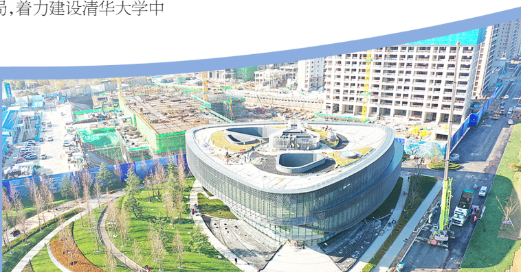
海洋活力区项目一期四号地块施工现场。
