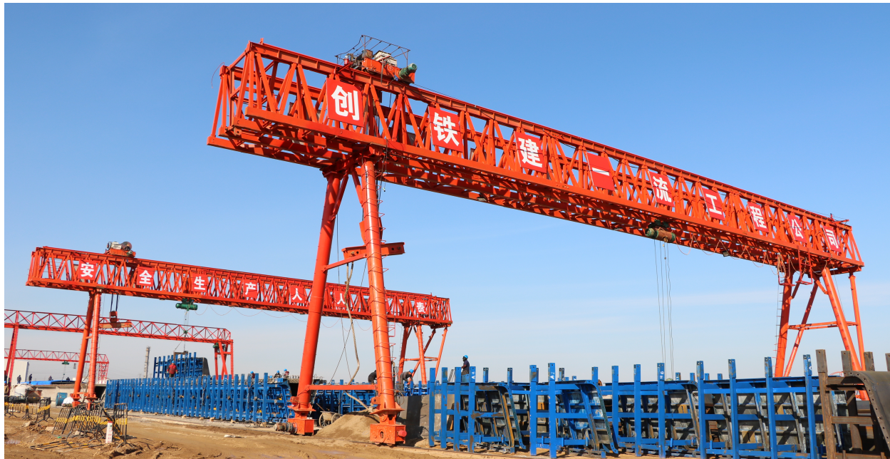
项目施工现场,5台龙门吊进行节段箱梁拼装作业。
