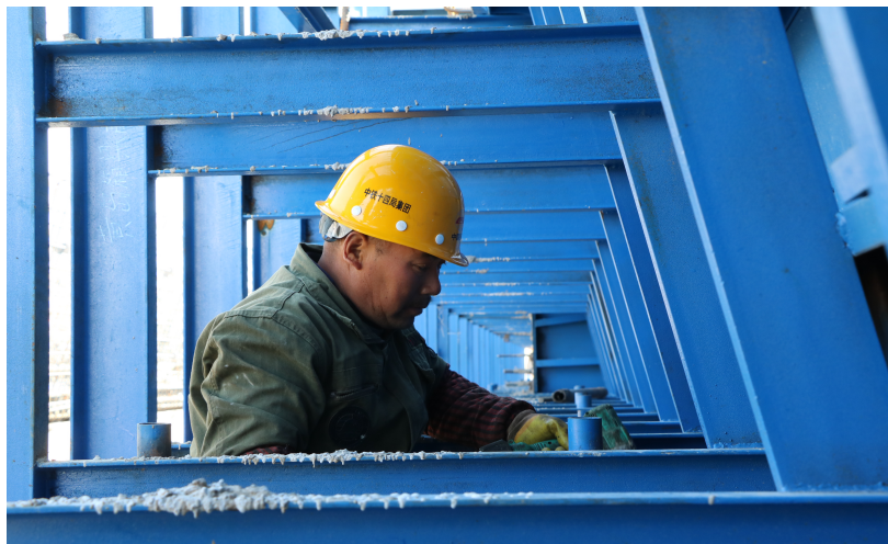
箱梁模板一侧,工人用工具将零件加固。
