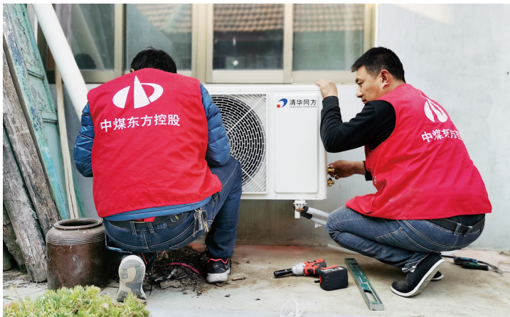
工作人员上门安装取暖设备。
