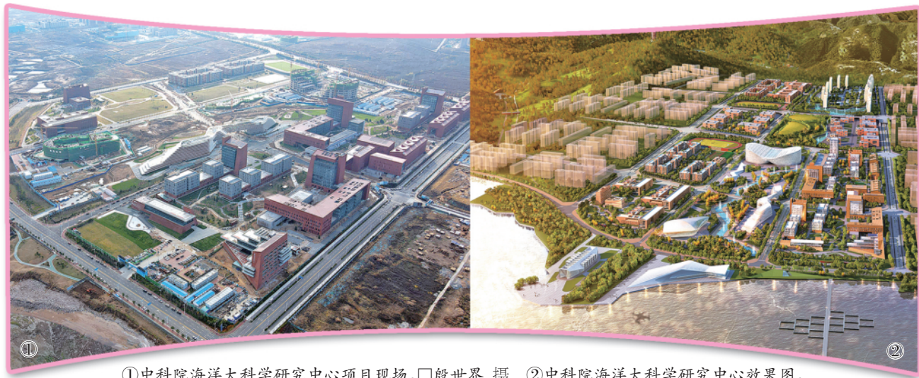
①中科院海洋大科学研究中心项目现场。□殷世界 摄 ②中科院海洋大科学研究中心效果图。
