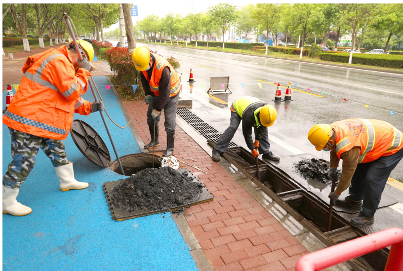
管线维保工人正在清理排水管网垃圾。□记者 张静 摄
