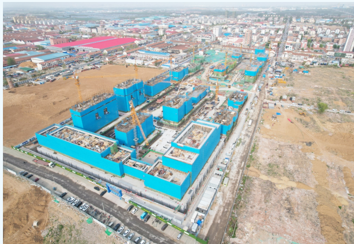
王台旧村改造二期项目建设现场
