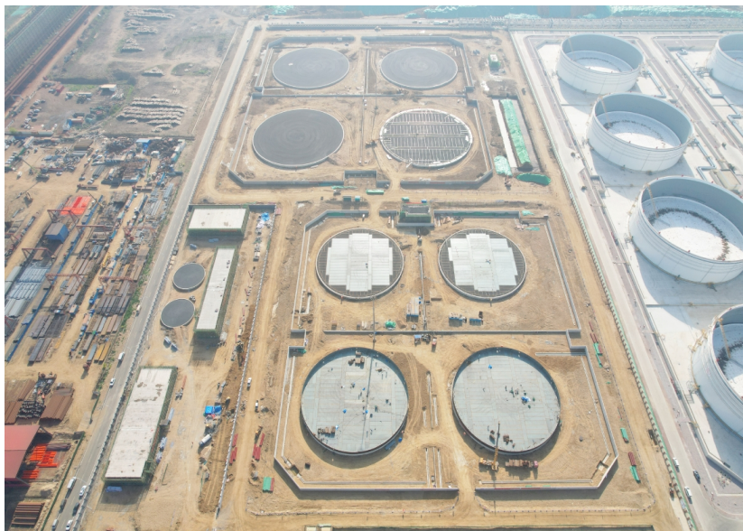
山东港口青岛港董家口港区齐鲁富海原油库工程建设现场
