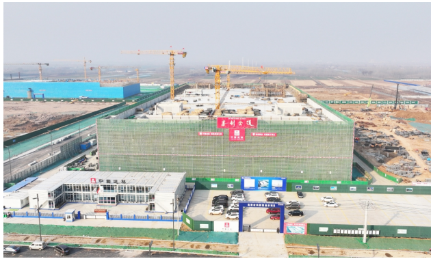
翰博光电生产基地项目主厂房封顶。
