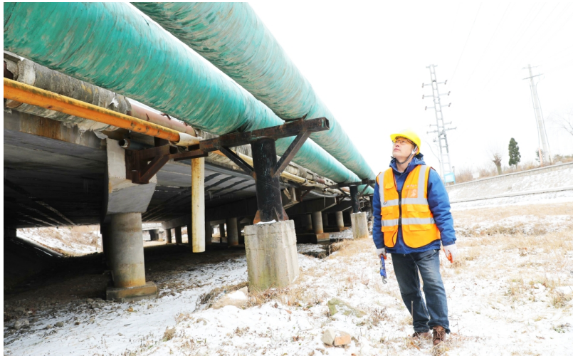
专业技术人员正在巡查供热管线。
