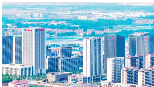
王台老工业区崛起“芯屏产业新城”。
