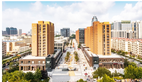
中电光谷成为全市“四新”经济策源地。
