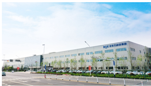
京东方物联网移动显示端口器件青岛生产基地
