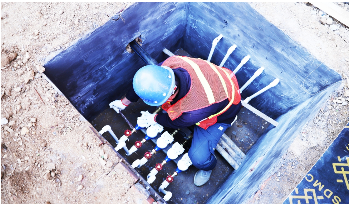
在东方花园小区，工人正在进行户表改造。
