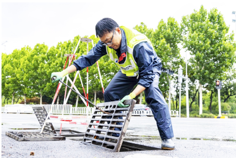
工作人员清掏雨水箅子,确保排水通畅。
