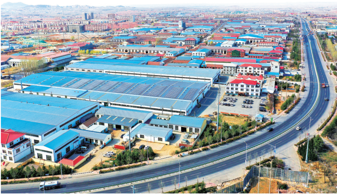
王台镇外环路双向四车道畅通无阻，未来将连接204国道，缓解城内交通压力。
