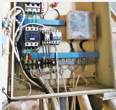
**存在问题:**青岛和德建材有限公司——部分用电设备及配电箱未采取接地保护。
