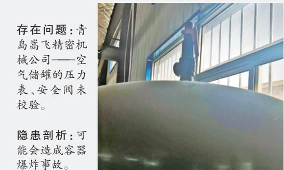
**存在问题:**青岛嵩飞精密机械公司——空气储罐的压力表、安全阀未校验。
