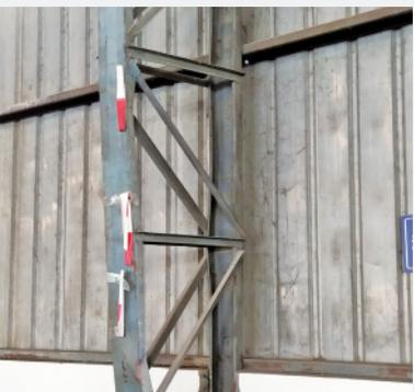
**存在问题:**青岛华伟杰汽车检测有限公司——车间北侧立柱结构破损。
