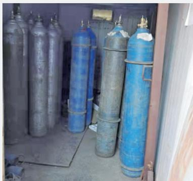
**存在问题:**黄埔车厢厂——部分气瓶未设置防倾倒装置,部分气瓶软管龟裂老化未更换。
