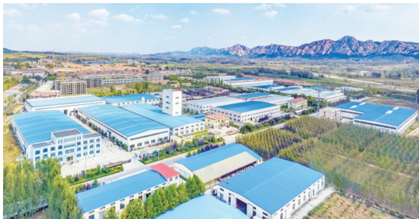
大村镇新型建材产业集群。(大村镇供图)
