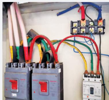
**存在问题:** 青岛优派普环保科技有限公司——除湿干燥机配电柜内电闸接线端子裸露,未采取隔离防护措施。
