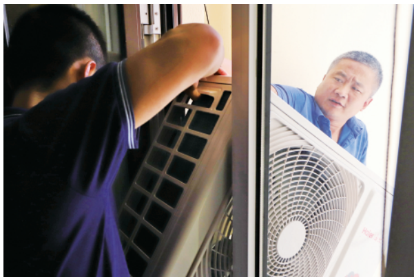
王元进和杨耀坤将空调外机从狭窄的窗口递到室外阳台。
