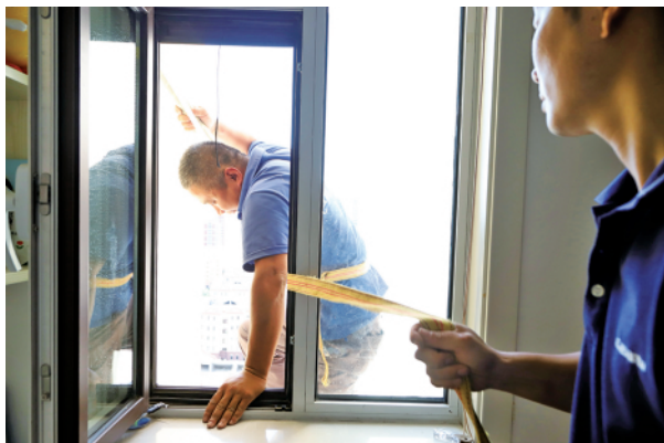
王元进系好安全绳后翻出窗外。准备安装空调外机。
