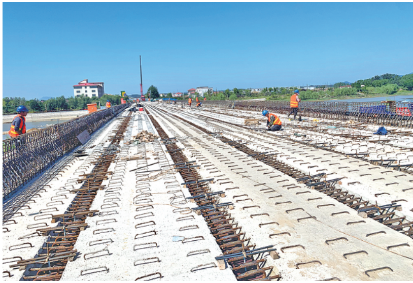
桥梁施工现场,工人正紧张地施工。
