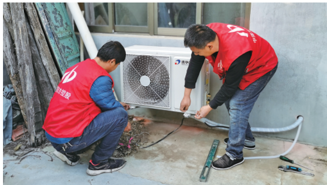
工作人员正在给村民安装空气源热泵。
