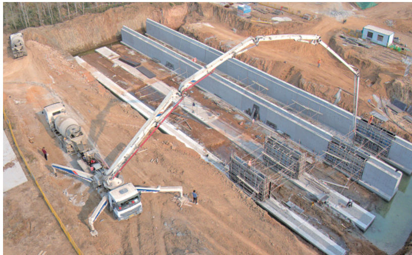
桥涵施工现场，泵车泵送混凝土施工。
