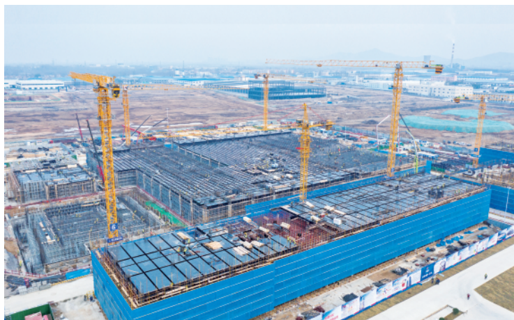
半导体高端封测项目施工现场。(融控集团供图)
