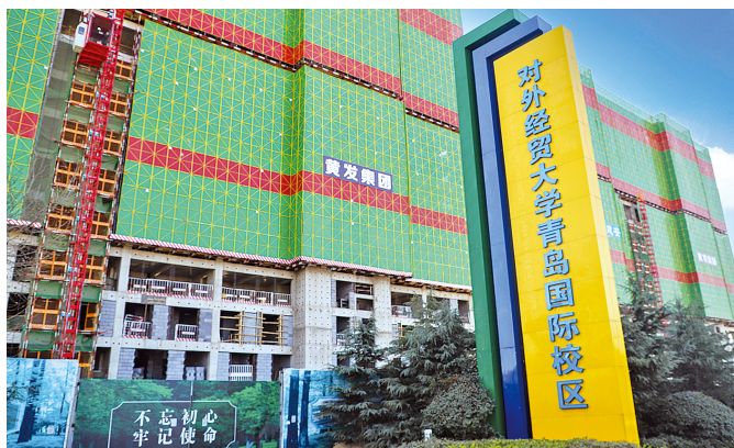
贸大青岛国际校区一期项目主体封顶。 □记者 刘腾 报道
