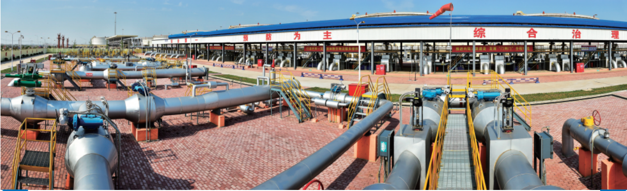
▲输油管道三期南线工程。
