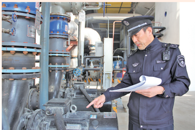
闫永强正在对易通热电公司换热站进行现场检查。
