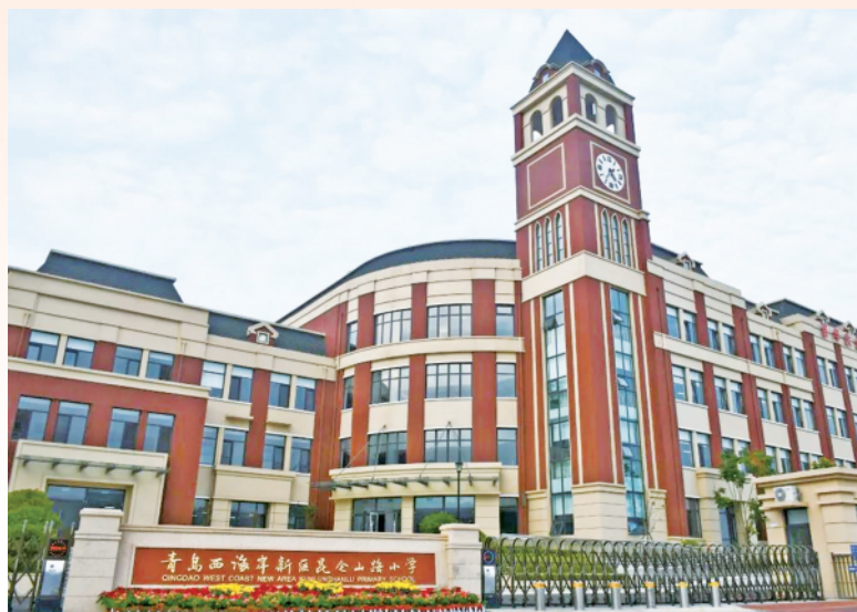
2019年建成启用的青岛西海岸新区昆仑山路小学。
