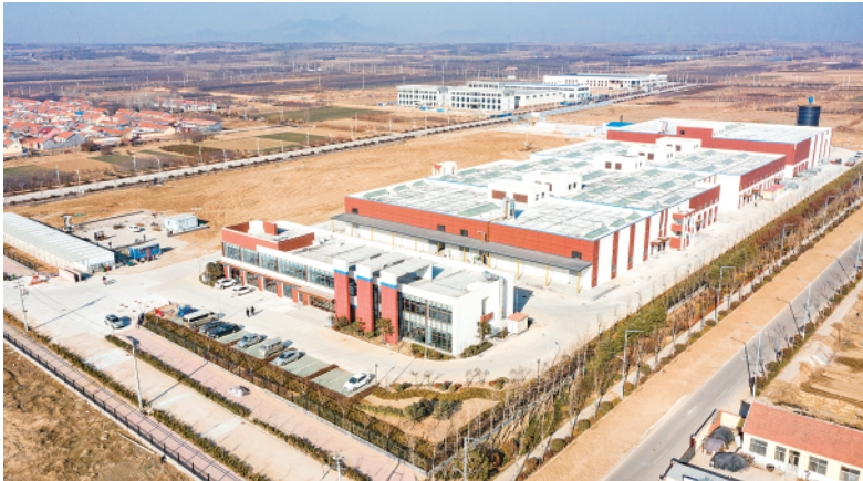
旅投集团投资建设的中粮山萃树果深加工产业园项目。
