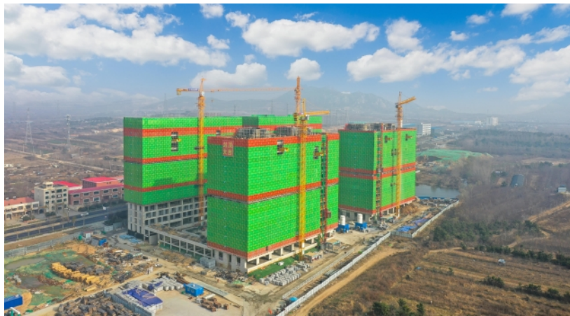
贸大青岛国际校区一期项目加速推进。
