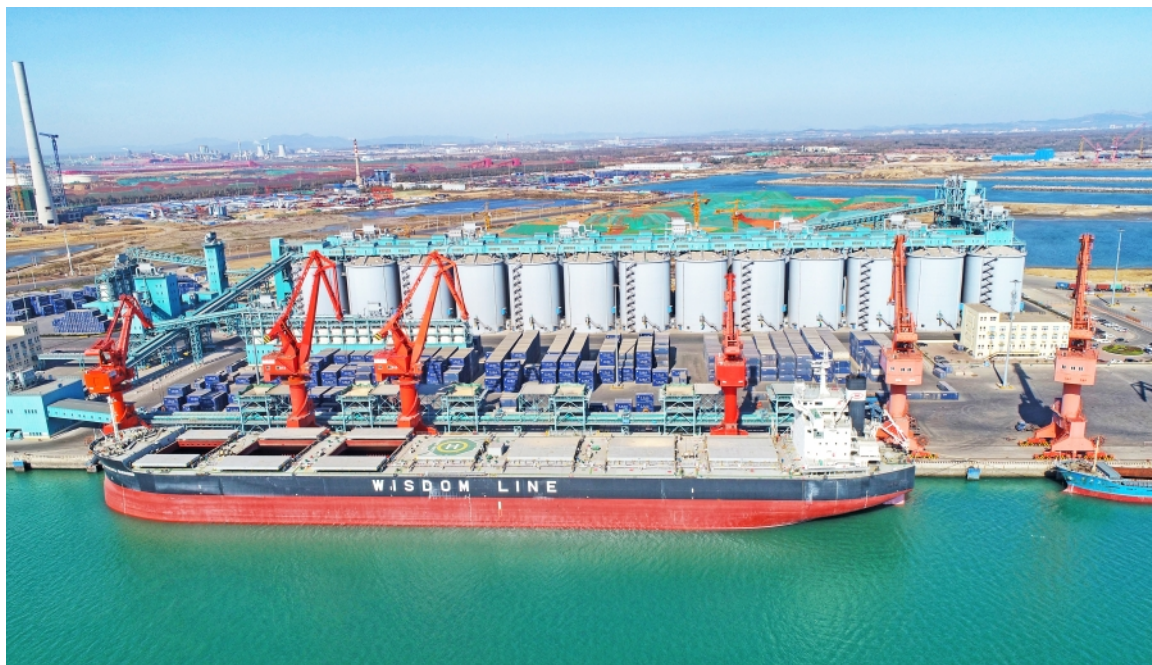
山东港口青岛港董家口港区北三突堤通用码头。□记者 李亮 摄(资料图)
