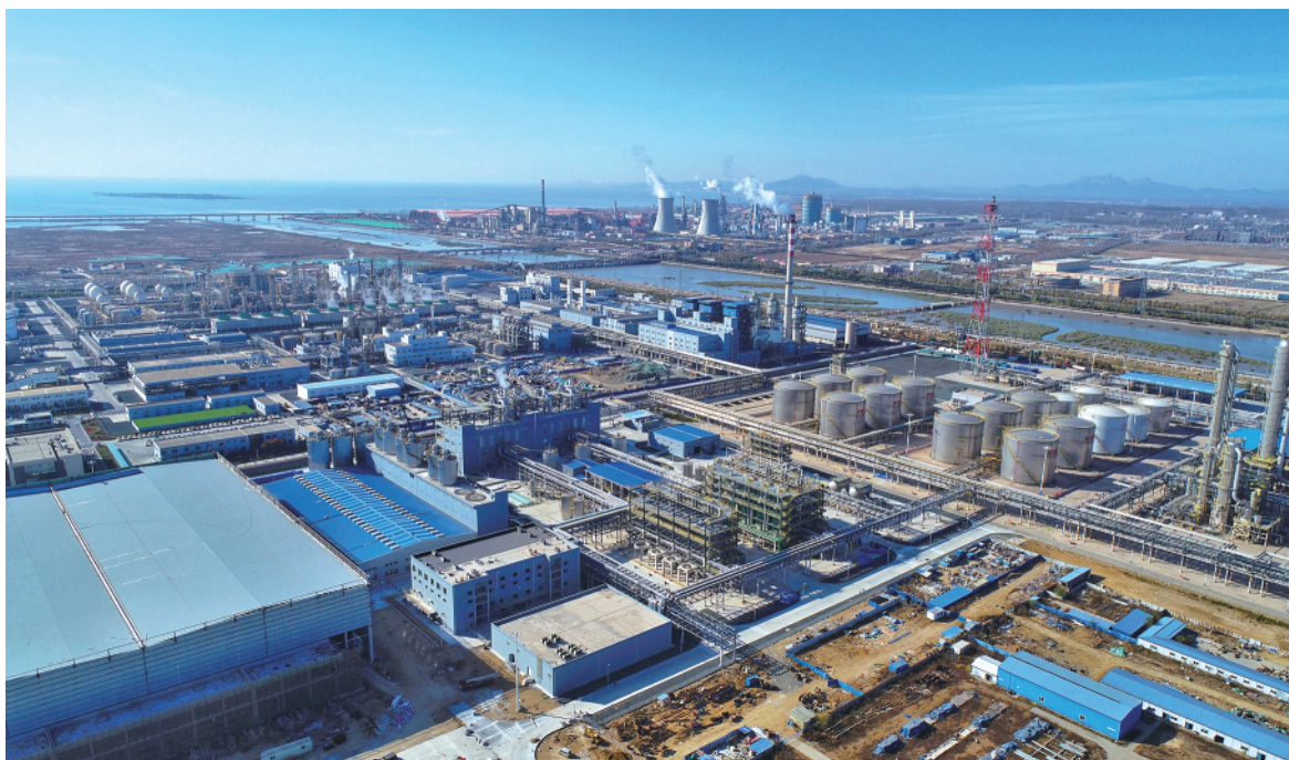
董家口经济区化工产业园航拍图。□记者 李亮 摄
