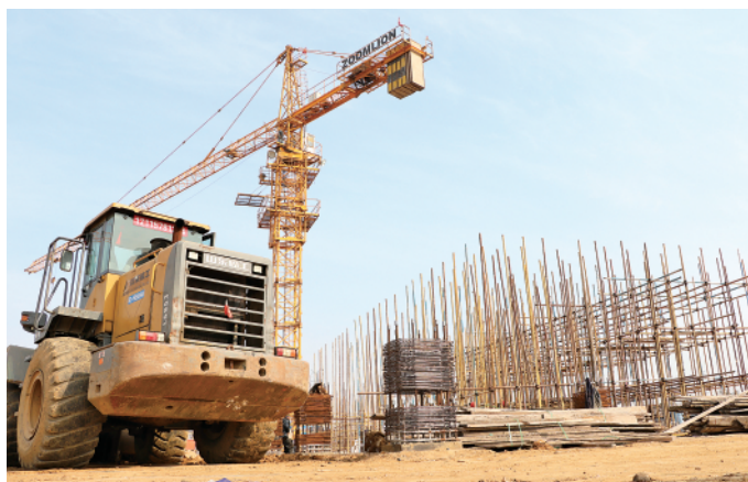
惠城科技FCC催化剂项目施工现场一派繁忙。□记者 董梅雪 摄
