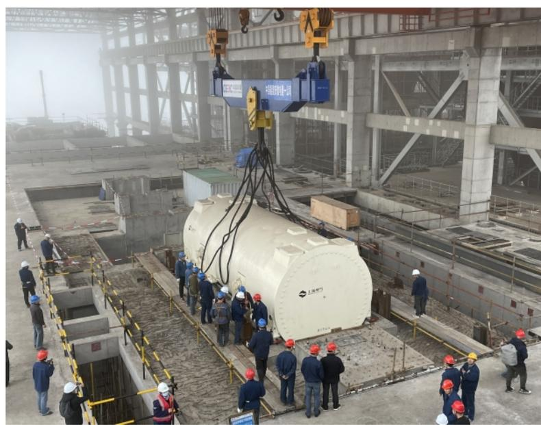
华能青岛董家口热电联产项目1号机组发电机定子顺利吊装就位。
