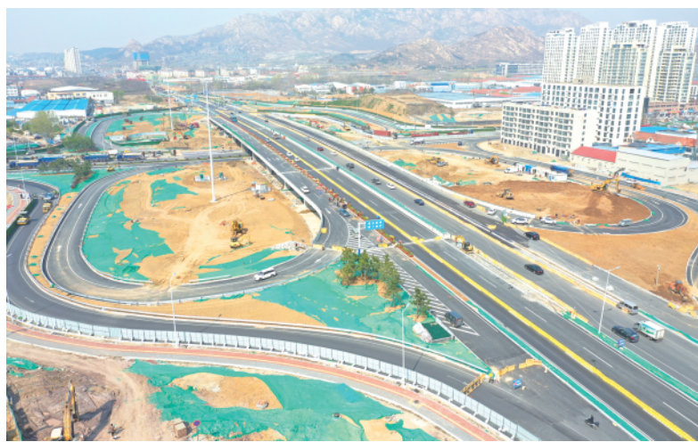
长昆立交工程预计6月底竣工通车。
