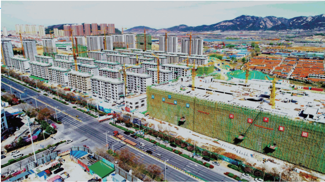
殷家河片区改造项目87栋单体已封顶。
