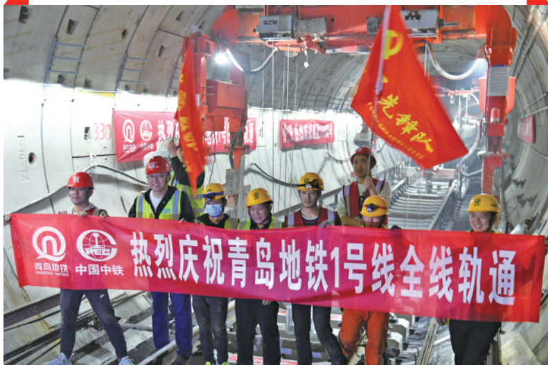
现场施工人员庆祝地铁1号线全线轨通。□新华社记者 李紫恒 摄
