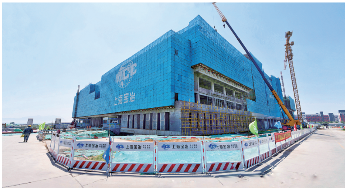
中国海洋大学西海岸校区一期工程施工现场。
