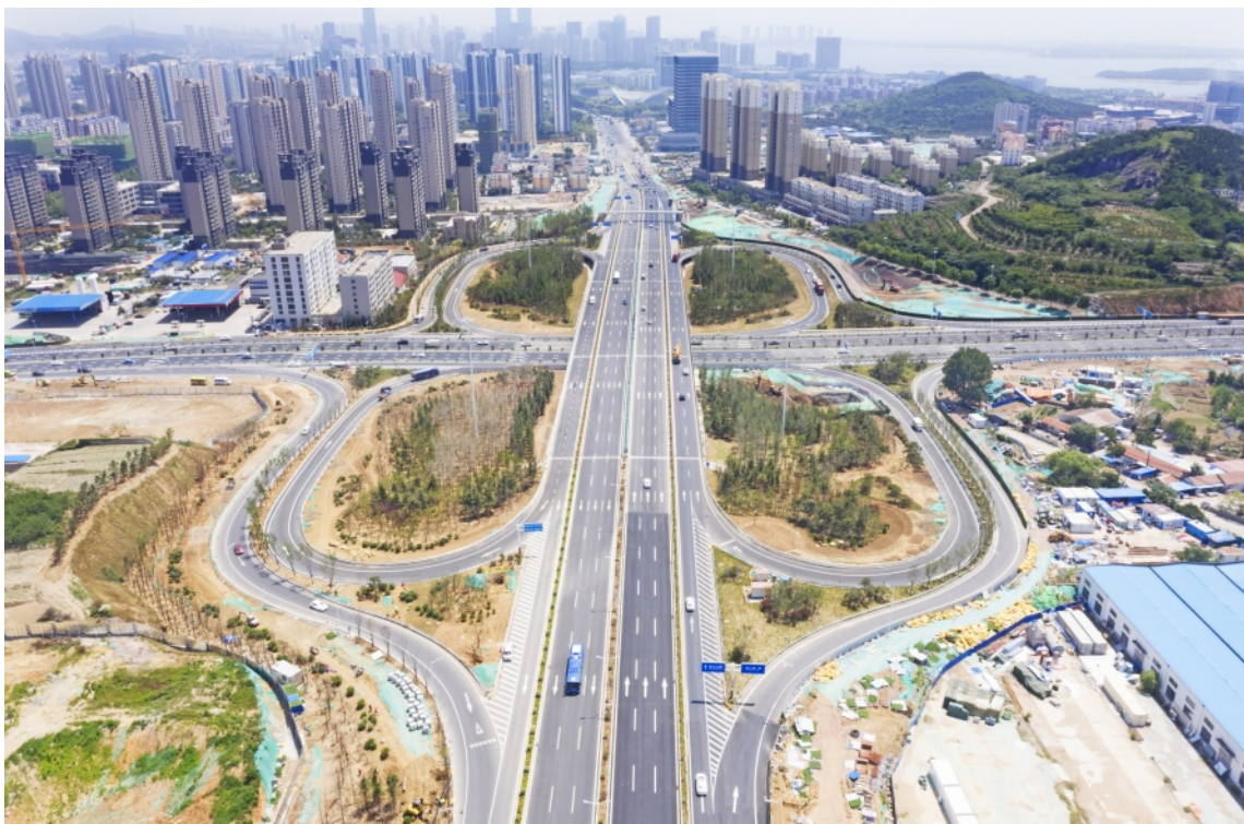
6月4日下午4时,长昆立交桥正式通车,这是西海岸新区第一个互通式立交桥工程。该项目有效缓解了昆仑山路和开城路交叉口道路拥堵问题,实现了长江路与开城路的直连直通。(区交通运输局供图)
