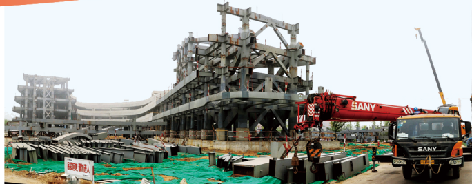
中央美术学院青岛校区施工现场。
