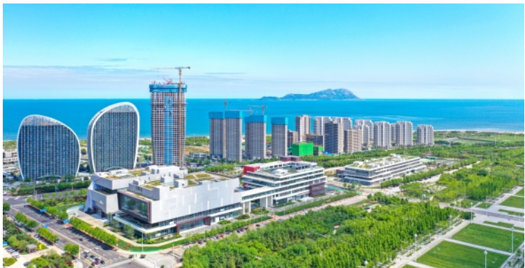
由黄发集团承建的西海岸新区市民文化中心项目。
