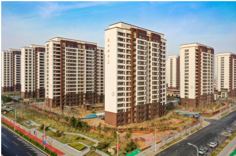
复兴社区采用先进建造技术，致力为回迁居民打造舒适的安置房。
