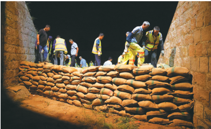
市政工人连夜筑坝,消除安全隐患。
