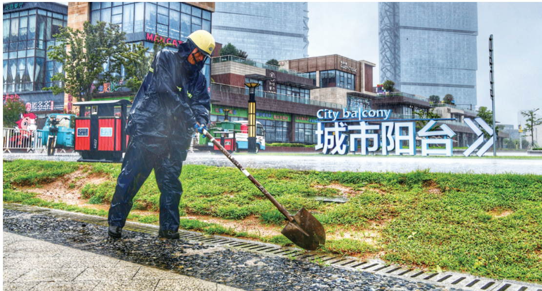
防汛工作人员护理排水设施。□记者 李亮 摄
