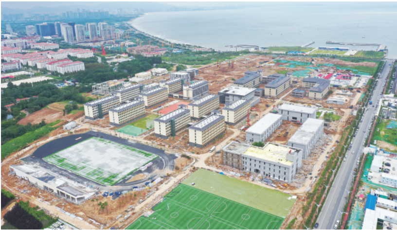
中国远洋海运大学新校区一期工程即将投用。
