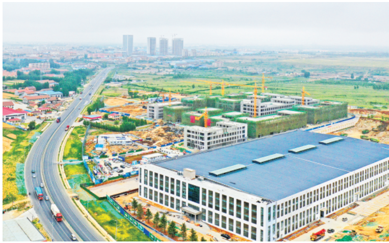
位于王台街道的青岛德盛利智能装备项目。
