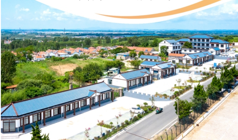
▼琅琊台景区西门改造提升项目。
