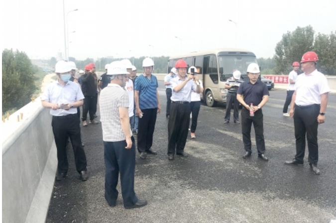
专家教授在道路建设现场查找安全隐患。
