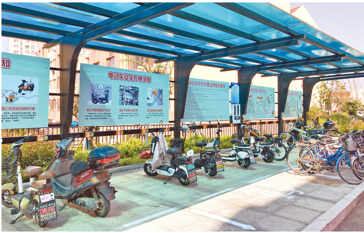
濠洼社区为居民增设电动车充电桩。□记者 丁霞 摄
