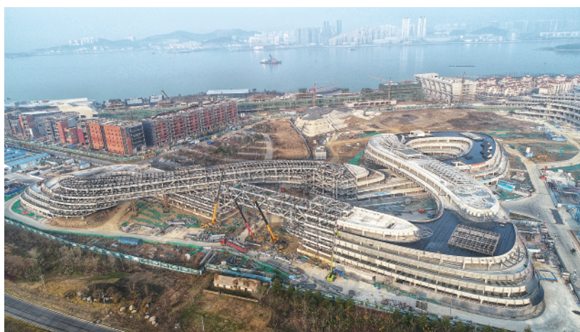
“莫比乌斯环”——教学综合楼体已顺利合龙。
