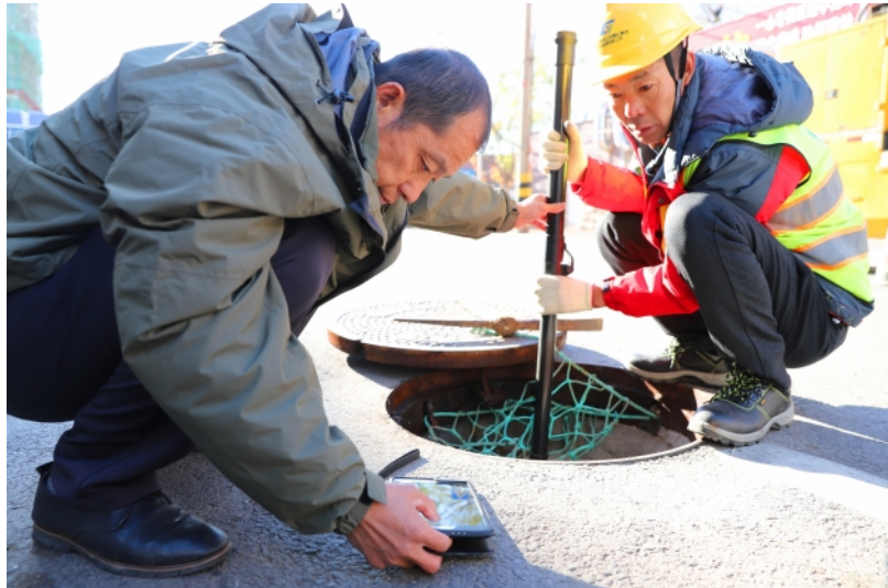
工人利用无线潜望镜观察管道内壁情况。
