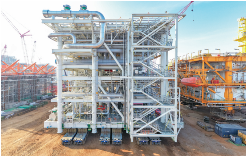
加拿大LNG项目A5EA模块高度超过13层楼,重量相当于近4000辆小汽车。
